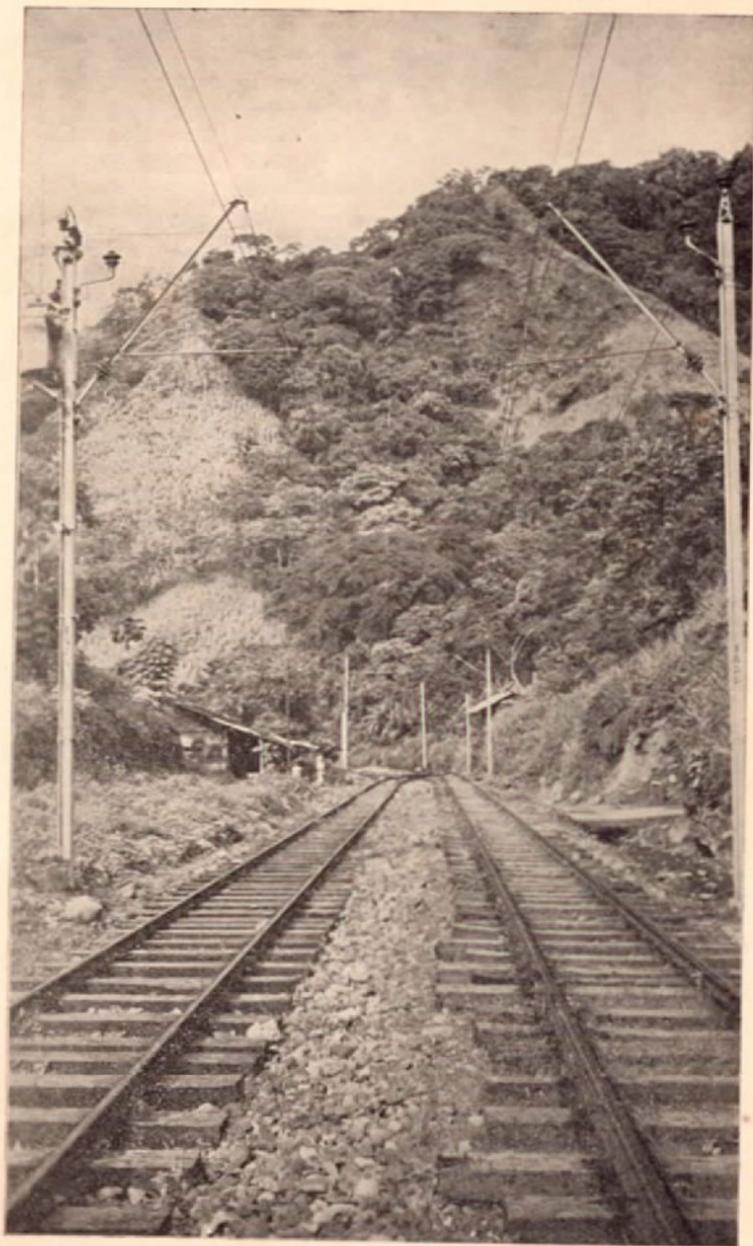
Sección en la que pueden apreciarse paralelamente la simetría y consistencia de un trecho de línea recientemente hecho y lo disparejo y falto de sostén de la trocha antigua.
